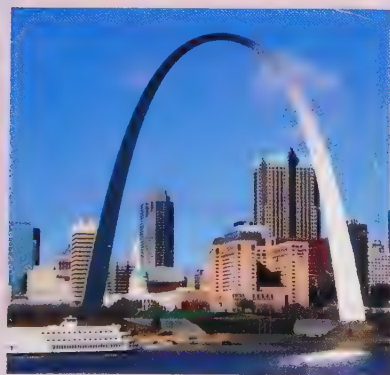
El arco Gateway , en Saint Louis (Misuri), es una catenaria aplanada, diseñada por el arquitecto finlandés-estadounidense Eero Saarinen en 1947.
