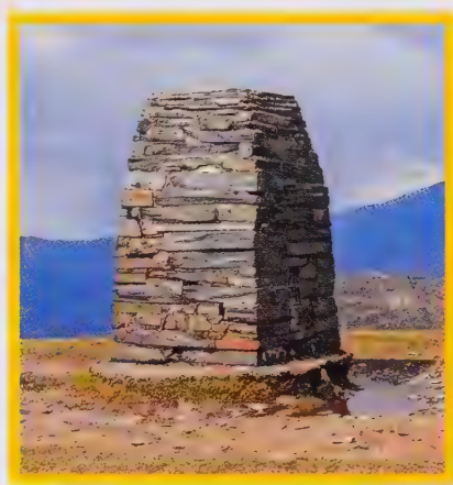
Para cartografiar la isla de Gran Bretaña con precisión, la Ordnance Survey creó en 1936 una red de estaciones de triangulación, entre ellos, este punto geodésico en Gales.
